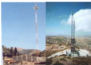
«Σχήμα 1. Αυτόνομο τηλεπικοινωνιακό σταθμό φωτοβολταϊκής βάσης (1α) και προτεινόμενη υβριδική λύση (1β)»
